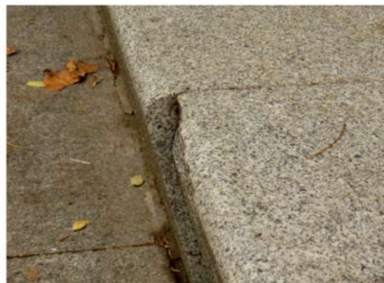
Figura 9. Fragmentaciones de aristas en banco de granito
