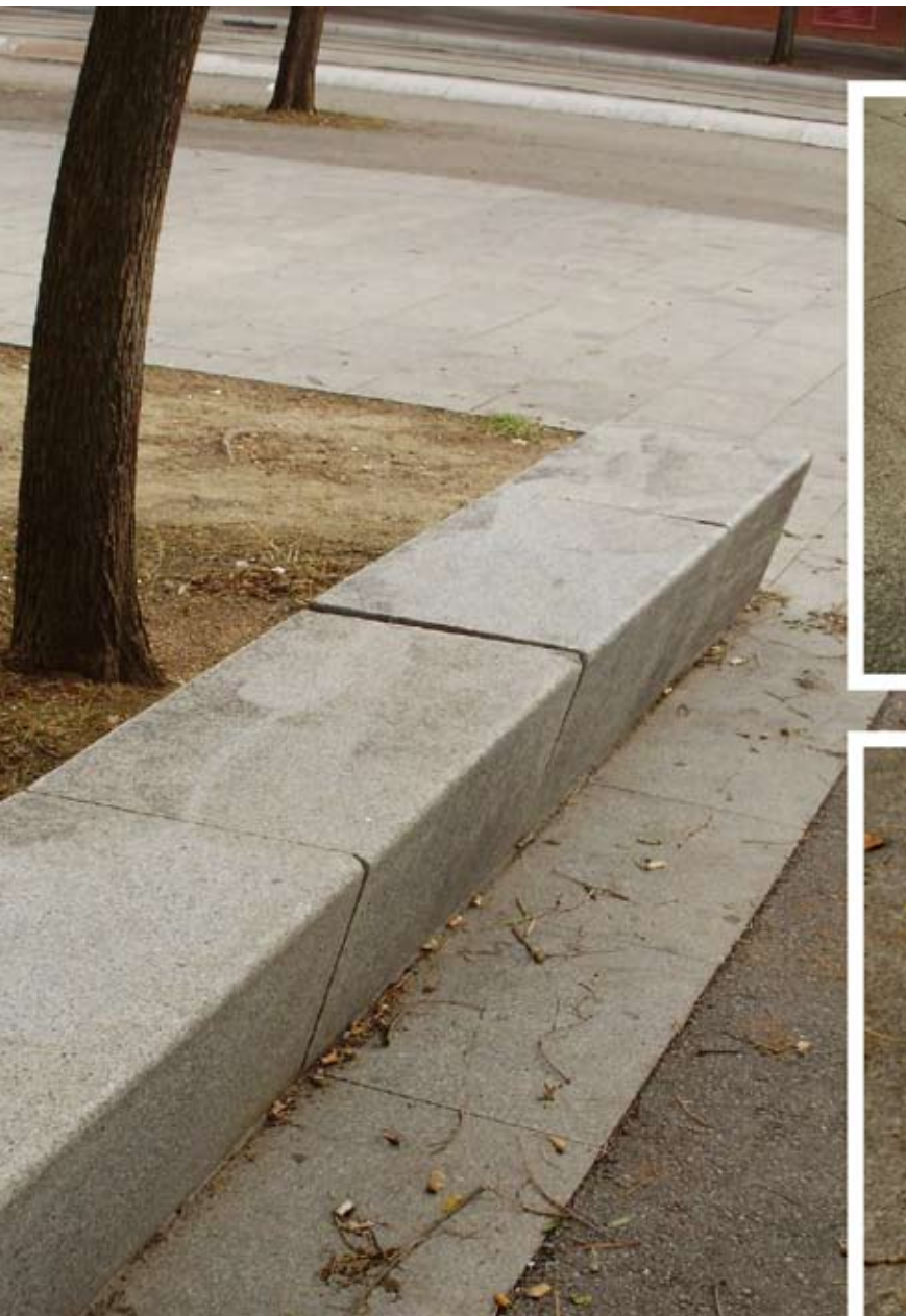
Figura 9. Fragmentaciones de aristas en banco de granito
