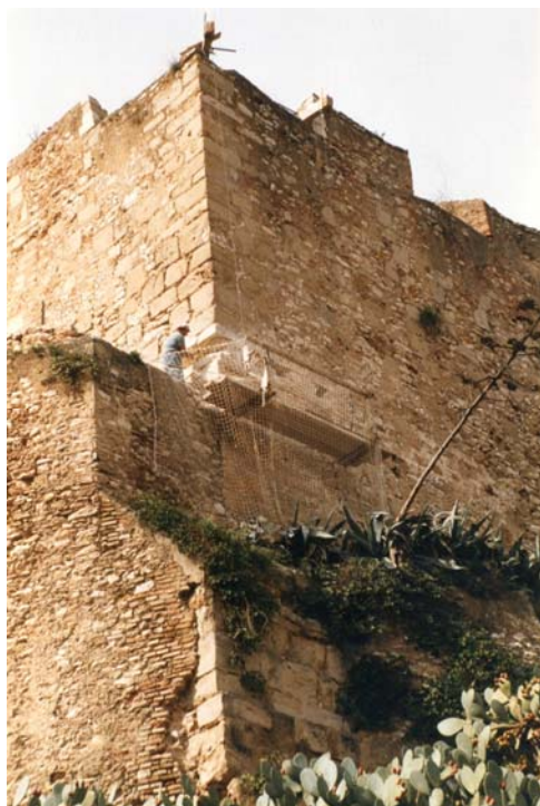
Fig. 11. Trabajos de recuperación de la estela de la nave del Palau de la Suda.
