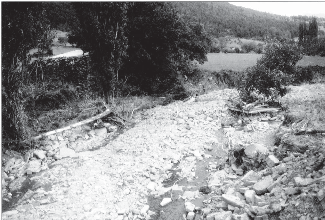
Foto 6.- Erosió lateral en el canal de Betés
