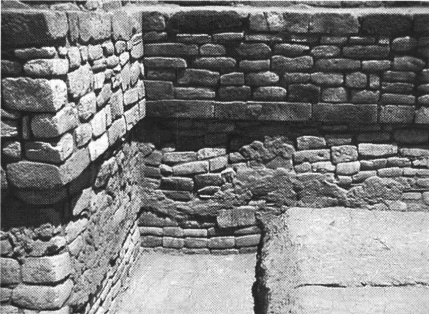
Foto 8 - Detalle del talud-tablero de la segunda etapa de construcción del basamento piramidal
