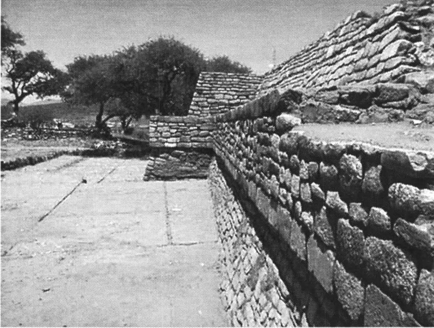
Foto 9 - Perspectiva de la fachada Sur del basamento piramidal. Al fondo se aprecia el quiebre del muro para formar la planta en T.
