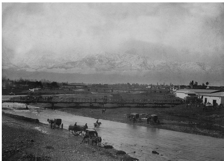
Figura 2. Puente de madera en el río Mapocho, vista hacia el oriente, c. 1870.
