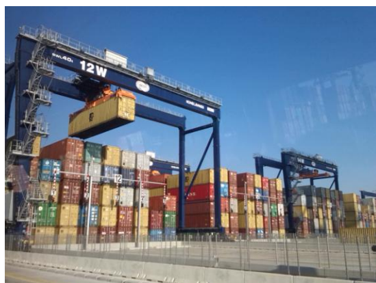
Figura 2 Barcelona Europe South Terminal (BEST). La moderna terminal internacional de mercancías que la empresa china Hutchinson Port Holdings en colaboración con TERCAT ha construido en el puerto barcelonés es un buen ejemplo del papel que el capital chino ejerce en el control de centros logísticos de alcance internacional fuera de su territorio estatal. Foto: Lluís Frago, 2014.
