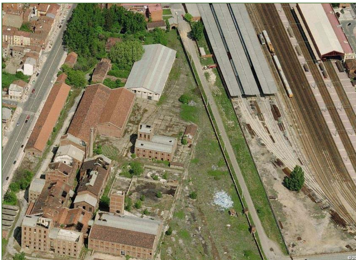
Figura 2. Instalaciones de la azucarera Santa Elvira en las inmediaciones de la parrilla de vías y estación de ferrocarril del Norte
