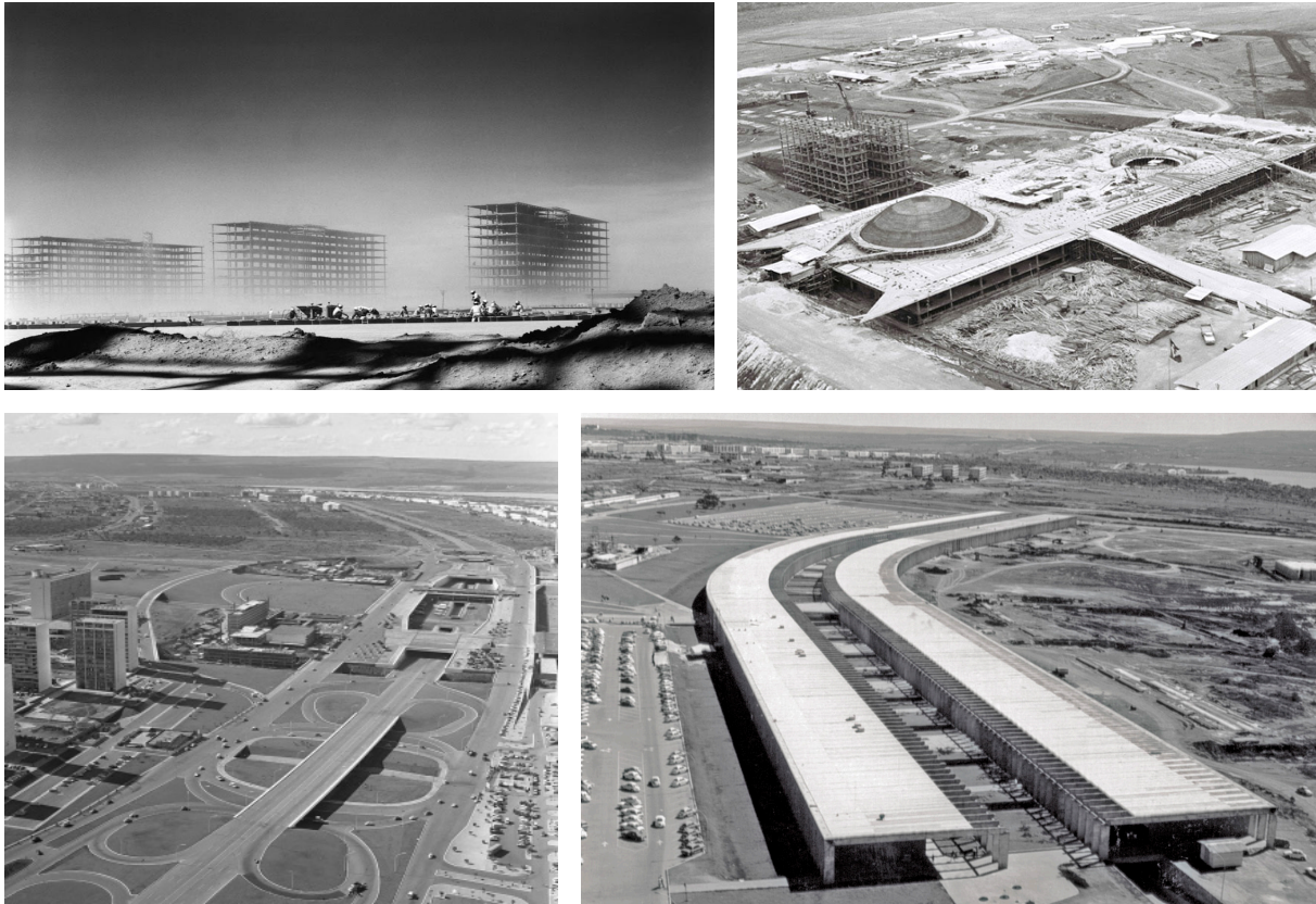
Fig. 05 – Construcción de Brasilia [1956-1960]. (i) Explanada de los Ministerios; (ii) Congreso Nacional; (iii) Eje Rodoviario y Plataforma de la Rodoviaria; (iv) Universidad de Brasilia/UnB.
