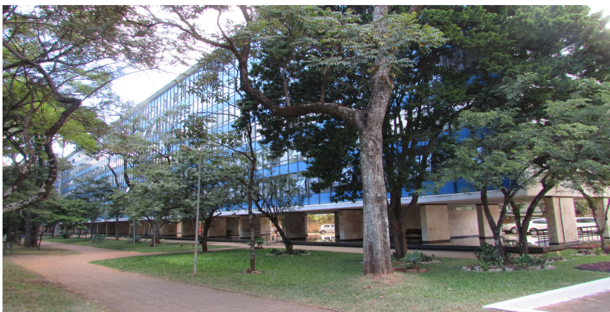
Fig 07 – Edificio sobre pilotes en la Supermanzana Modelo de Brasilia (308) [escalas residencial y bucólica]. Fuente: Acervo de los autores. Junio de 2018.
