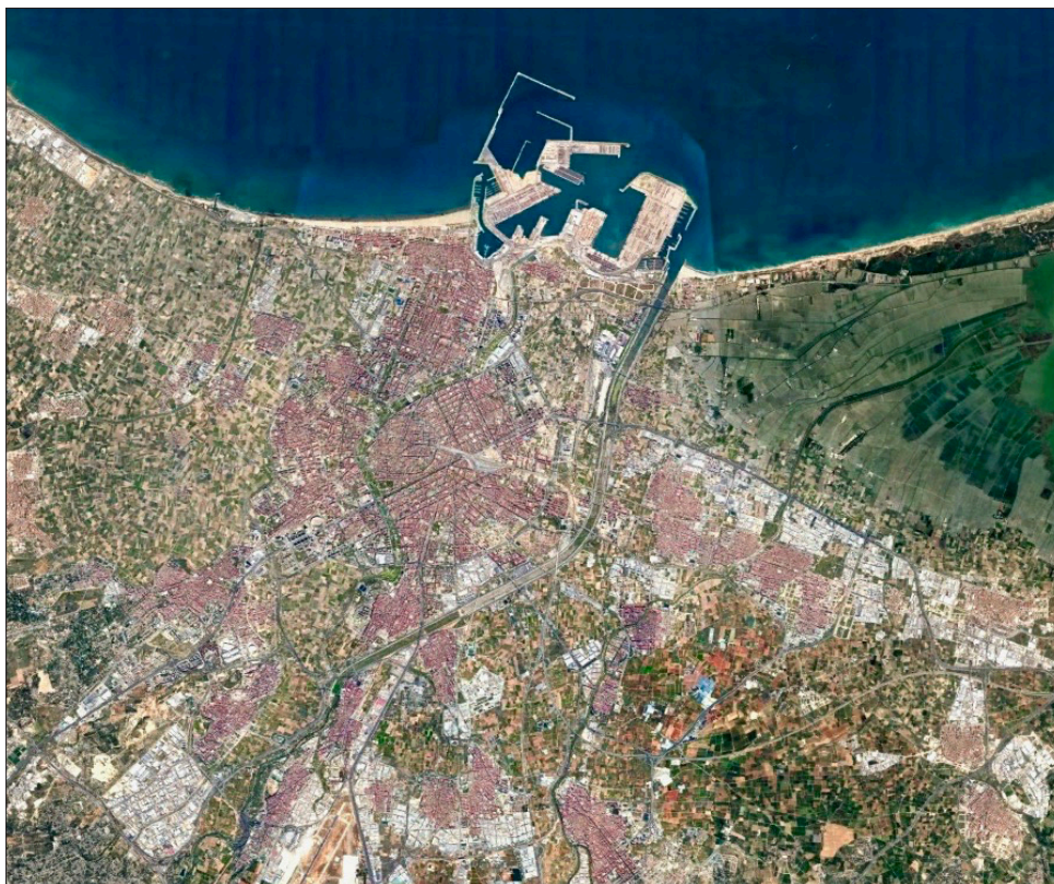
Figura 2: Fotografía aérea en la que se pueden apreciar los dos cauces. A la izquierda, realizando una apreciable curva, el cauce antiguo en la zona céntrica de la ciudad, hoy parque urbano. A la derecha de la imagen el nuevo cauce con un trazado inicialmente rectilíneo. Posteriormente despliega una amplia curva y desemboca en el mar.
