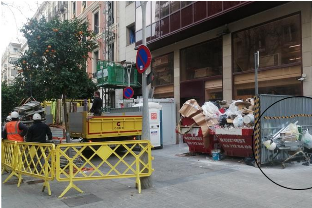
Figura 2 Baye a la espera y trabajando junto a una obra en proceso en el distrito de Sant Martí, Barcelona, 01-12-2018.
