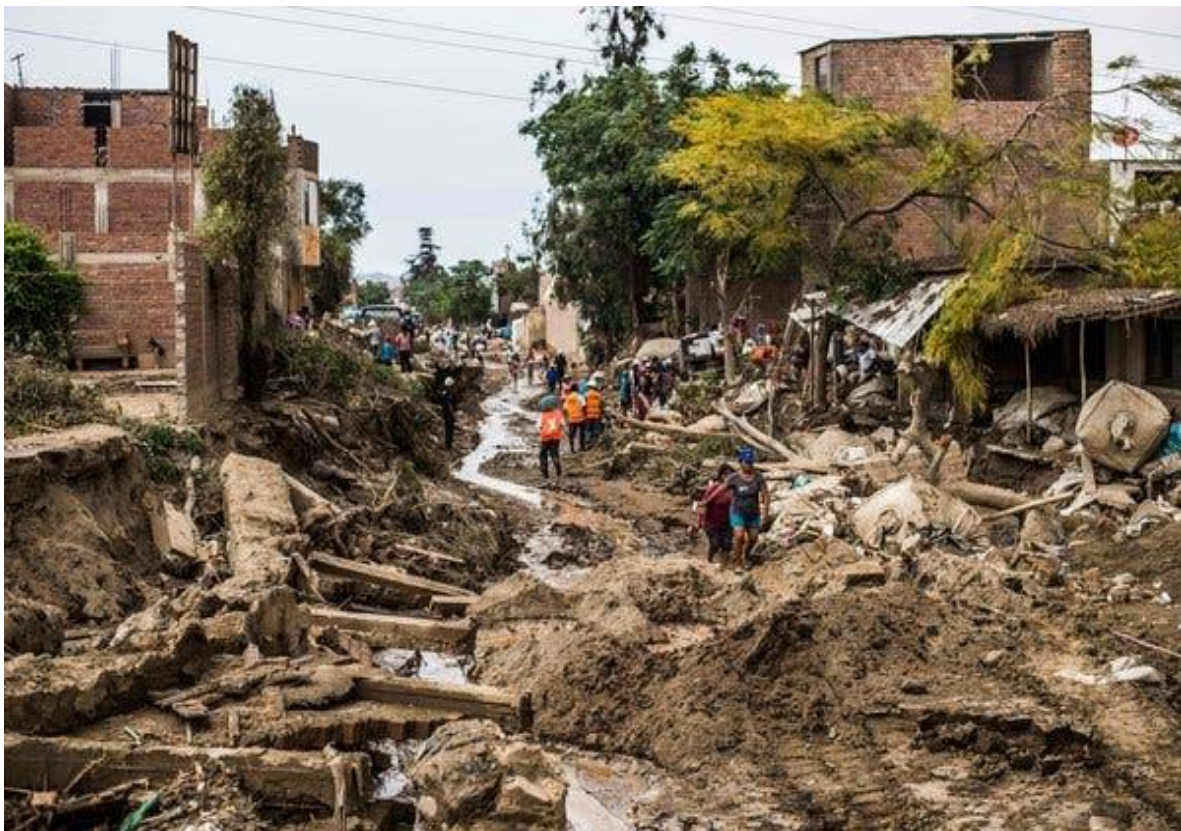
Figura 4. Efectos de las inundaciones de Huachipa (Lima) provocadas por el fenómeno de “El Niño” de 2017
