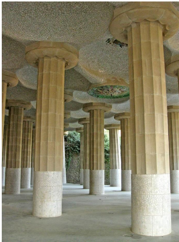
Figura 5. Detalle de las columnas de la Sala Hipóstila del Park Güell
