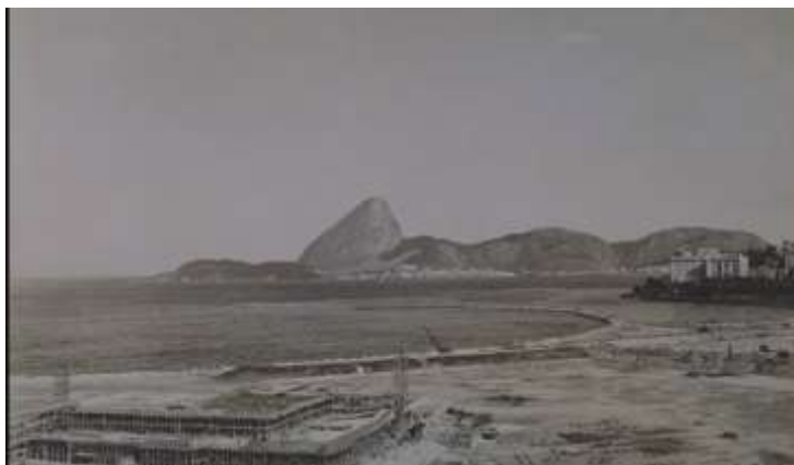
Figura 3. Fotografia do início da construção dos equipamentos no Parque do Flamengo
