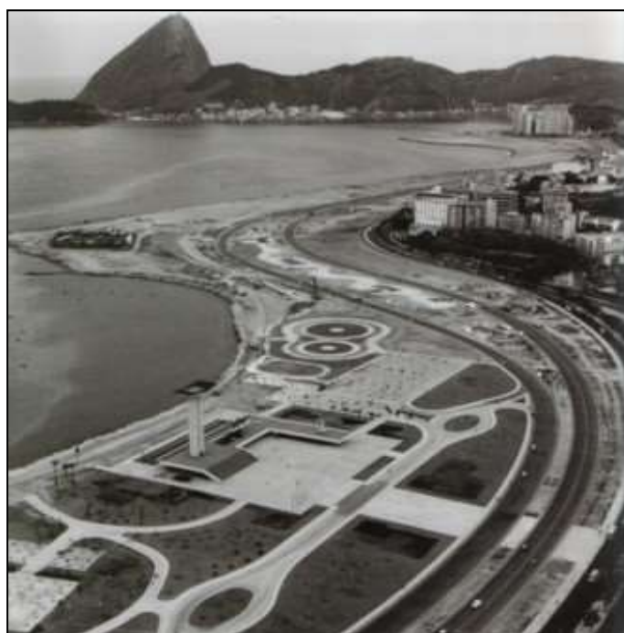
Figura 7. Vista em construção do Aterro do Flamengo
