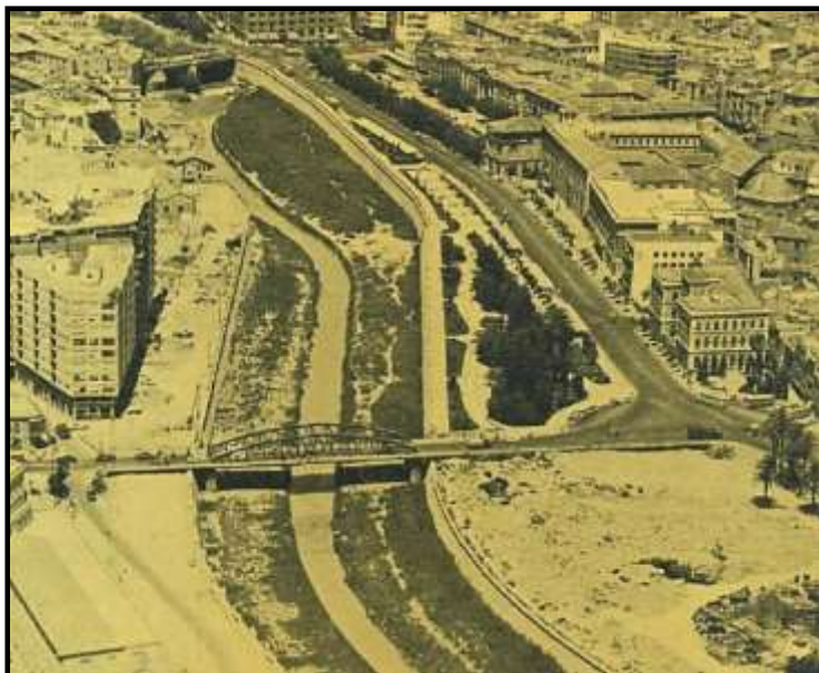
Figura 32. Antes de comenzar las obras de la parte oriental, 1968.
