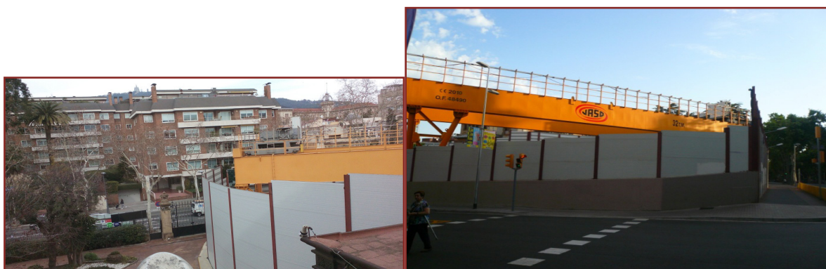
Figura 18 La grúa de las obras de la línea 9 del metro de Barcelona en la entrada del edificio.
