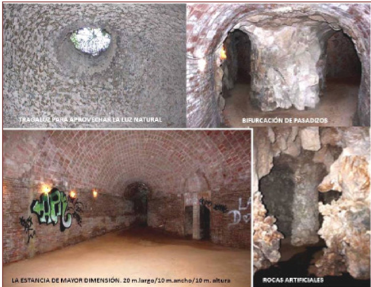
Figura 22. Estado actual del interior de las grutas subterráneas de la finca Altimira.
