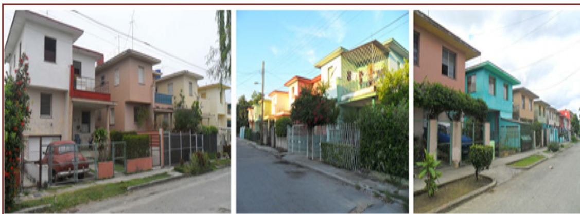
Figura 11. Vistas actuales de los conjuntos en los repartos Residencial Casino Deportivo (11a), Nueva Habana (11b) y Víbora Park (11c).
