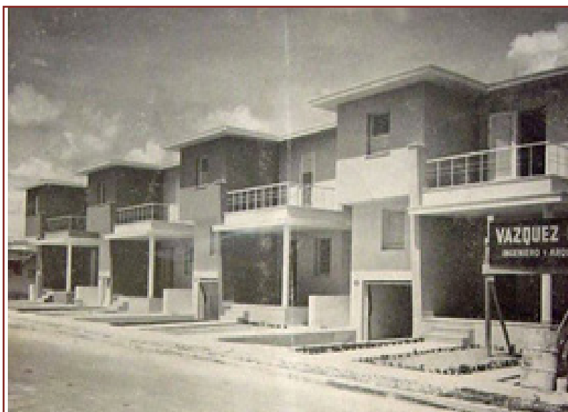
Figura 5. Conjunto en el reparto Residencial Casino Deportivo
