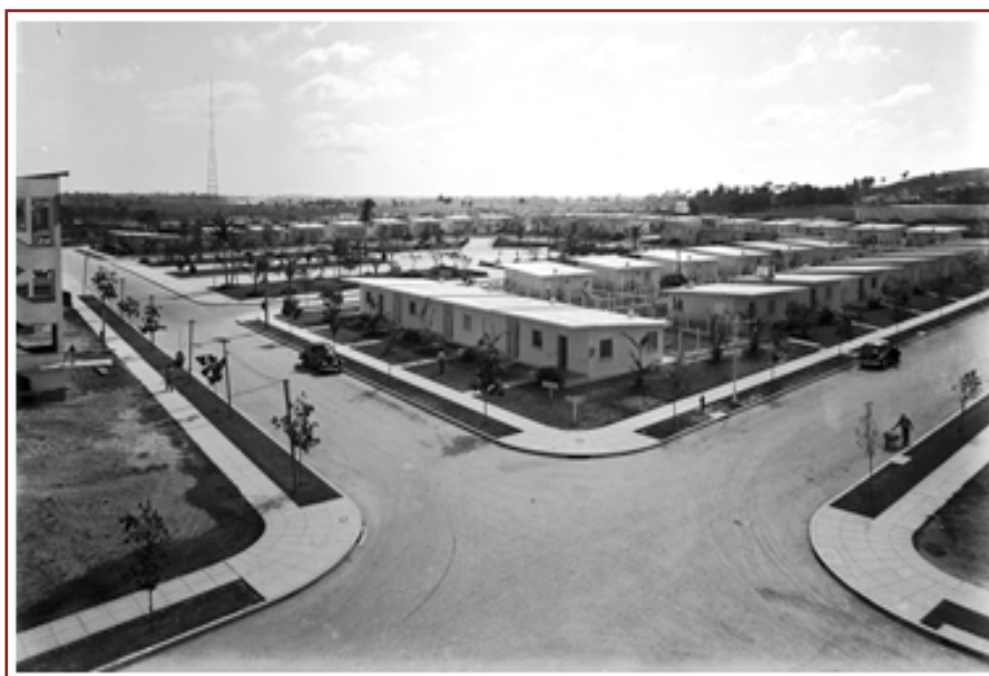
Figura 2 Barrio Obrero de Luyanó, La Habana (1948)
