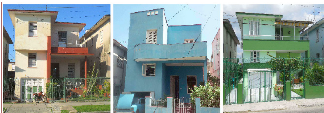
Figura 7. Viviendas independientes de dos plantas con rasgos formales del Movimiento Moderno en los repartos El Sevillano (7a), Alturas de Ayestarán (7b) y Residencial Casino Deportivo (7c).
