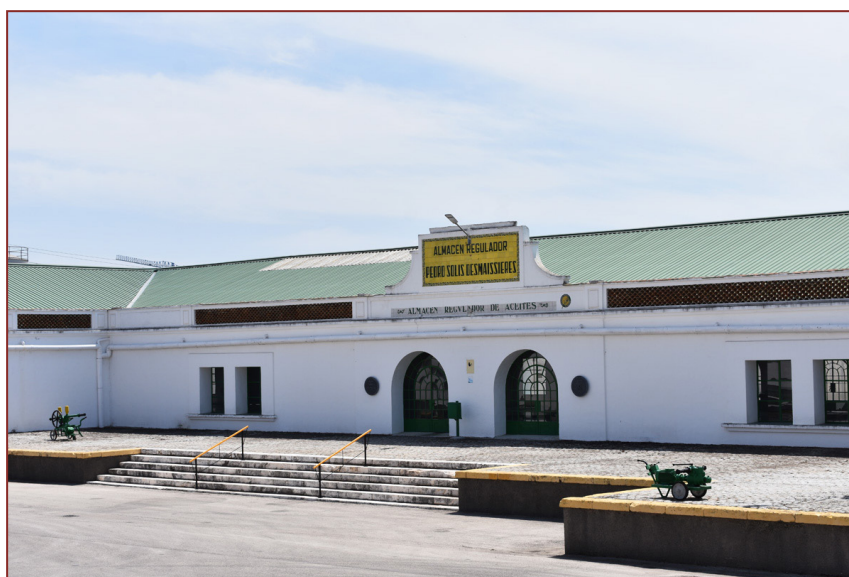
Figura 3. Almacén regulador de aceite de Puente Genil (Córdoba)
