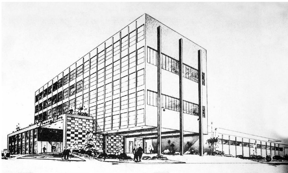
Figura 2. Edificio sede de Prensa Libre en 1958.
