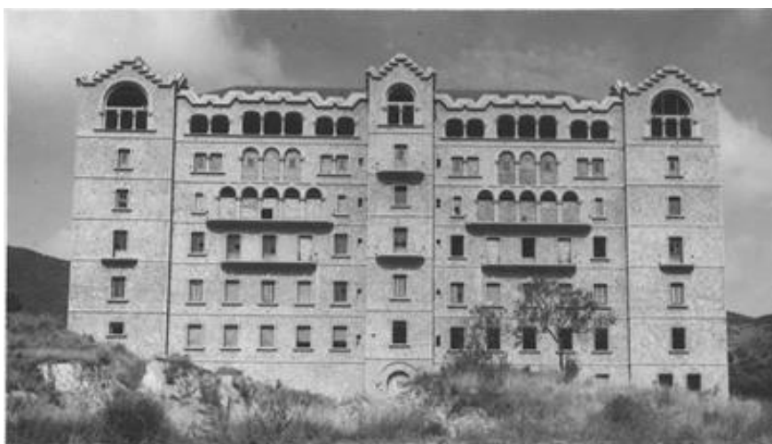
Figura 7. Fachada principal del Pabellón Levante en la Torre dels Frares, 15 de octubre de 1946.
