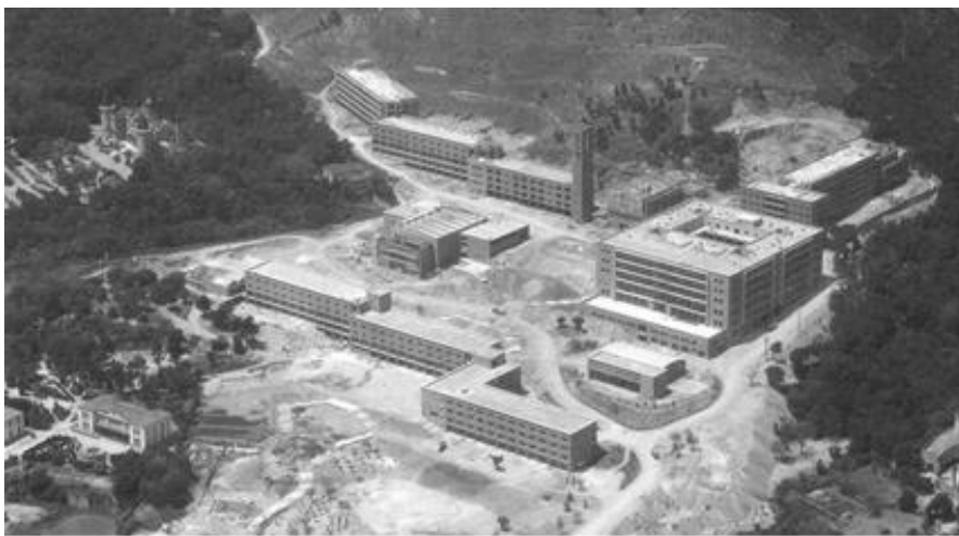
Figura 9. Hogares Mundet en construcción, 1956.
