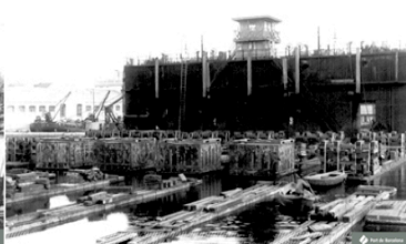
Reparación de una de las secciones del Dique Flotante 1908
