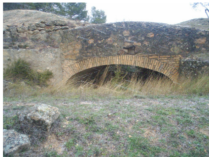
Figura 2. Exterior d'una casamata
