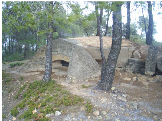
Figura 4. Correcció de tir. Vista de l'exterior
