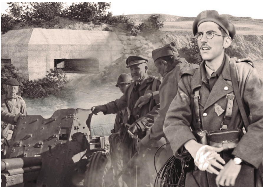
Construcción de posiciones antitanques en la zona de Raimats. Fotomontage realizado con la participación de recreadores y el uso de la técnica Matte-painting .
