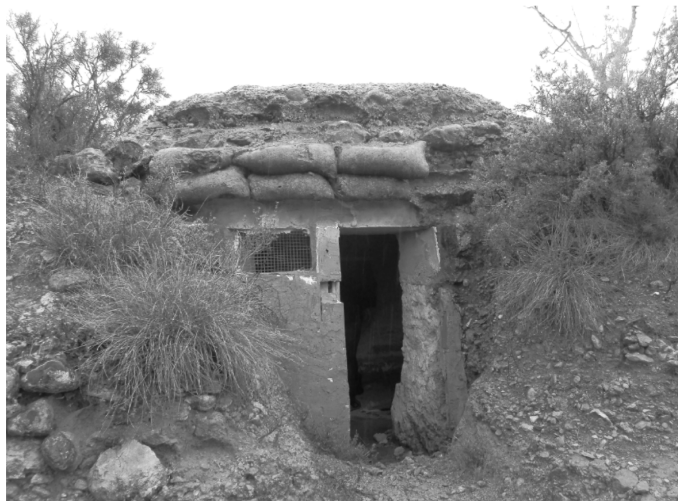
Imatge 2: Niu de metralladores reconvertit en caseta d'apers de llaurança a la línia de la Muela-Aceitenebro. S'observa la forma dels sacs de formigó utilitzats durant la seua construcció. Fons fotogràfic de l'autor per al projecte Rutes de Memòria.
