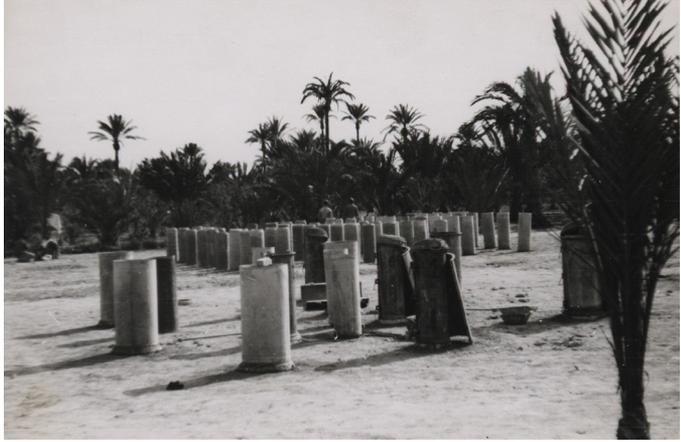
Fig. 5. Proceso de desmolde y secado de los tubos de hormigón fabricados por los presos del campo. Escrito a mano en el reverso: *Labor constructiva. Albaterra. Fabricación de tubos de cemento para conducción de agua (Reportaje Caireles; 12 febrero)*. Fuente: Biblioteca Digital Hispánica (Biblioteca Nacional), GC-CAJA/106/1/4, Albaterra (Alicante). [Campo de concentración]. Reportajes Gráficos Luis Vidal.
