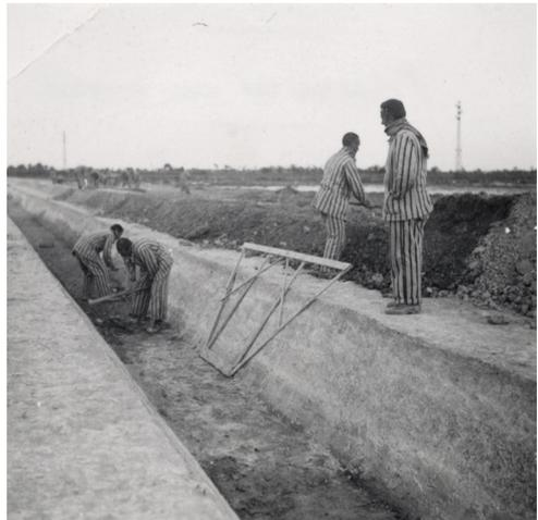
Fig. 6. Excavación de canalización para riego. Legenda: *Guerre civile d'Espagne 1936-1939. Entre Alicante et Murcia. Camp de travail d'Albaterra. Prisonniers au travail. Construction de canaux destinés à irriguer 200 hectares. À droite, terrain destiné à la plantation de légumes*. Fuente: Archivo fotográfico del Comité Internacional de la Cruz Roja, V-P-HIST-02224-25A.
