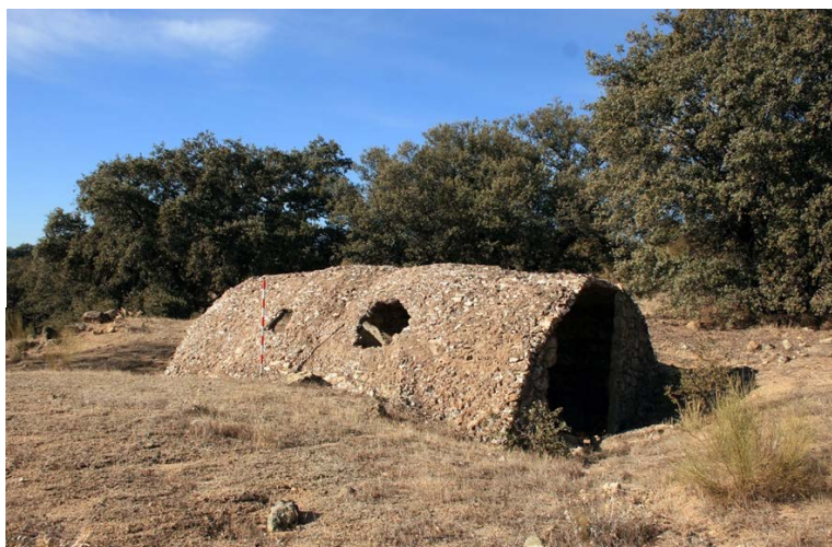
Figura 9. Catenaria híbrida en Navalagamella. Los tramos centrales son de doble curvatura, mientras que los de los extremos son rectos. Foto: autores.
