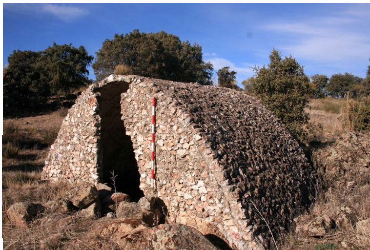
Figura 14. Catenaria en Navalagamella de superficie rugosa. Foto: autores.
