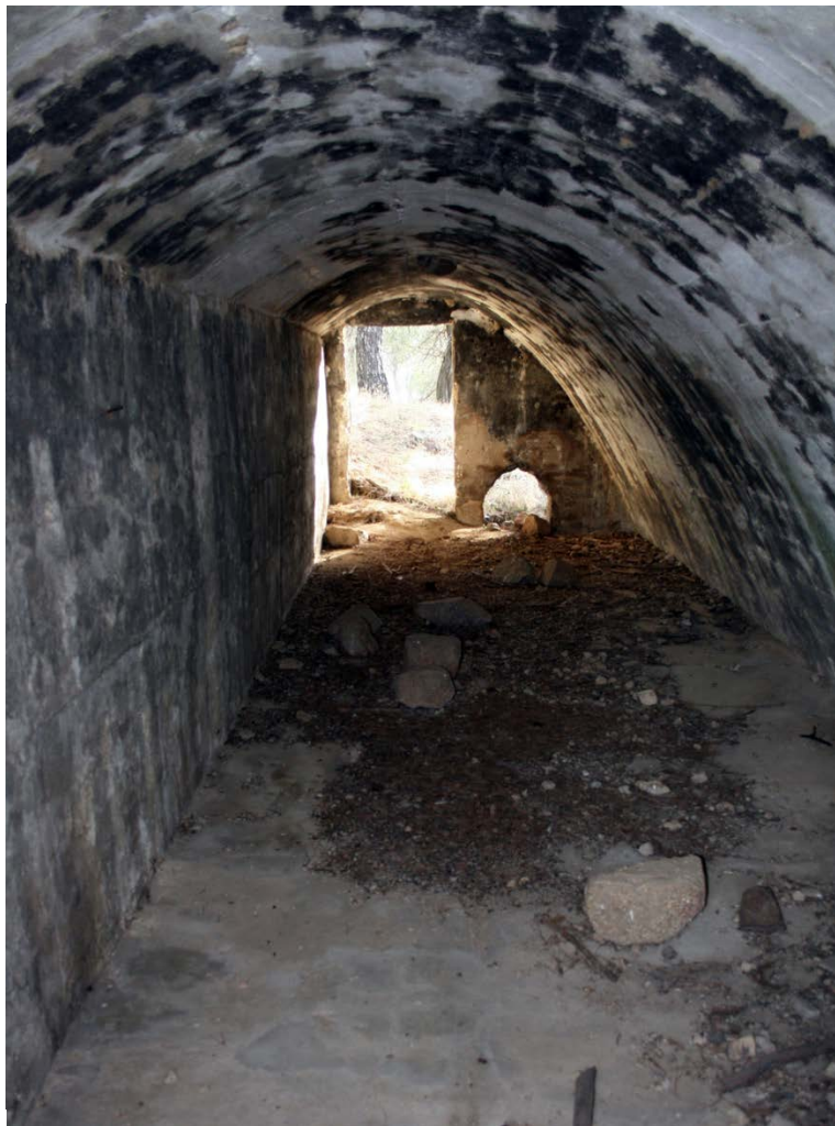
Figura 8. Interior de una catenaria de tres cuartos en Navalagamella, semejante a las que ilustran el artículo de Ejército. Foto: autores.
