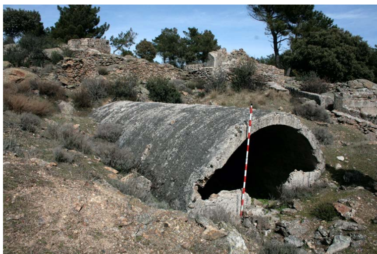
Figura 13. Catenaria blindada en Santa María de la Alameda, documentada en el proyecto citado del IGME. Foto: autores.
