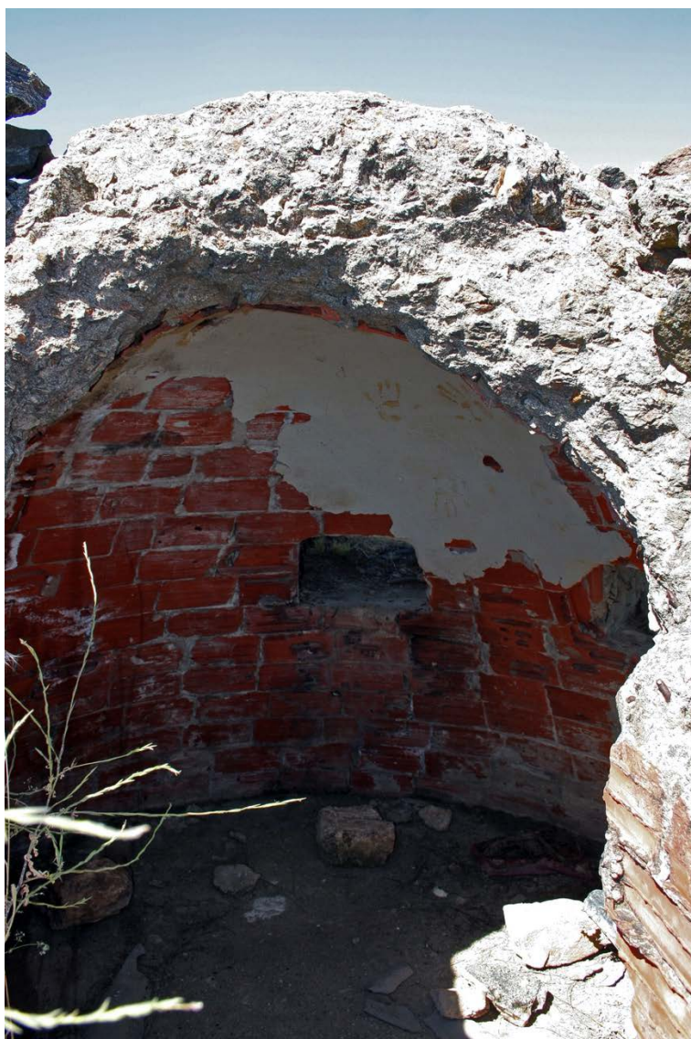
Figura 19. Obra blindada activa construida sobre una bóveda tabicada catenaria en Robledo de Chavela. Foto: autores.
