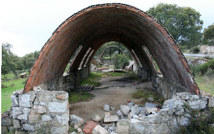
Figura 20. Catenarias en un campamento de Hoyo de Manzanares. Foto: autores.
