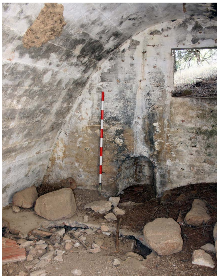
Figura 16. Chimenea y gloria en un abrigo de Navalagamella. Foto: autores.
