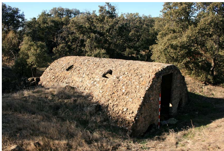
Figura 5. Catenaria con tragaluces en Navalagamella. Foto: autores.
