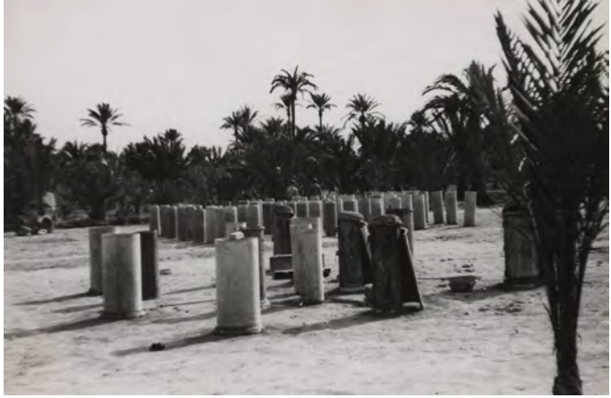
Fig. 5. Procesos de desmolde y secado de los tubos de hormigón fabricados por los presos del campo. Escrito a mano en el reverso: Labor constructiva. Albatera. Fabricación de tubos de cemento para conducción de agua (Reportaje Caireles; 12 febrero) . Fuente: Biblioteca Digital Hispánica (Biblioteca Nacional), GC-CAJA/106/1/4, Albatera (Alicante). [Campo de concentración]. Reportajes Gráficos Luis Vidal.
