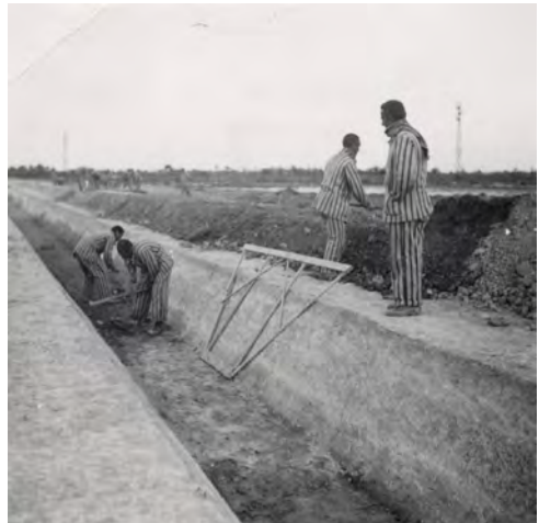
Fig. 6. Excavación de canalización para riego. Leyenda: Guerre civile d'Espagne 1936-1939. Entre Alicante et Murcia. Camp de travail d'Albatera. Prisonniers au travail. Construction de canaux destinés à irriguer 200 hectares. À droite, terrain destiné à la plantation de légumes . Fuente: Archivo fotográfico del Comité Internacional de la Cruz Roja, V-P-HIST-02224-25A.
