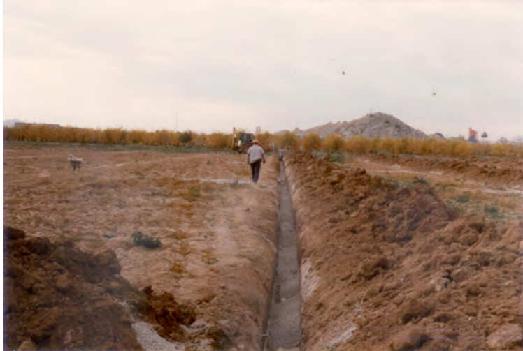
Fig. 25.- Excavación de zanjas en el término municipal de San Isidro para la evacuación de aguas salobres mediante tubos de drenaje. Año 1977. Durante la ejecución de estas tareas en las parcelas próximas a la ubicación del campo aparecieron las fosas con restos humanos que ahora hemos localizado. Fuente: Archivo Damián Sabater Culiñez.
