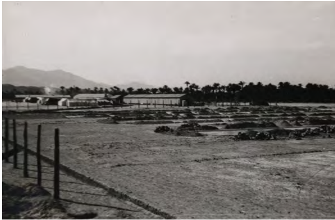
Fig. 16. Vista panorámica del campo orientada hacia el suroeste; al fondo, la sierra de Callosa se recorta sobre el horizonte. En primer término aparecen ya avanzados los trabajos de cimentación de varios barracones. Escrito a mano en el reverso: Labor constructiva et. Campo Albaterra. (Reportaje Cai-reles: 12 febrero) . Fuente: Biblioteca Digital Hispánica (Biblioteca Nacional), GC-CAJA/106/1/6, Albaterra (Alicante). [Campo de concentración]. Reportajes Gráficos Luis Vidal.
