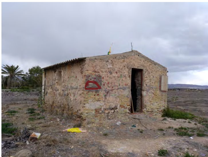
Fig. 24. Caseta donde estuvo el horno vista desde el sureste. La fachada actual corresponde al frontal de ladrillo refractario donde se empotraban las compuertas: una de las bocas fue tapiada con mampostería y la otra habilitada como puerta de acceso al habitáculo cuando se desmanteló la instalación (compárese con la imagen del horno en funcionamiento de la figura 12).
