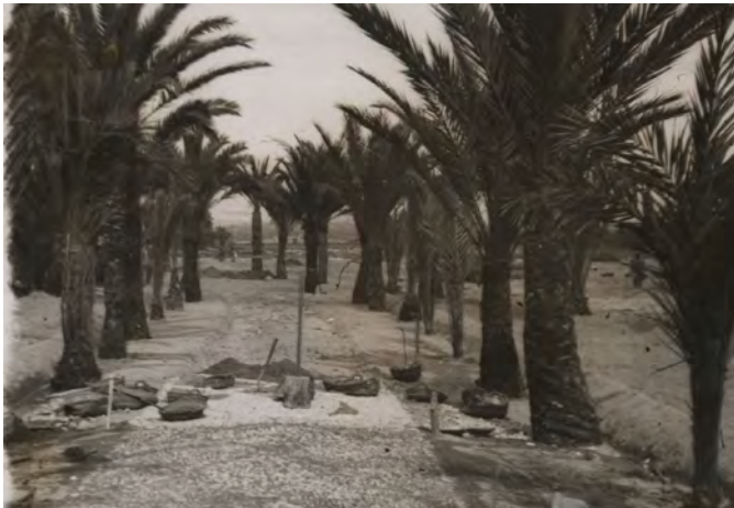
Fig. 8. Construcción de un camino de piedra apisonada en las inmediaciones del campo de trabajo. Escrito a mano en el reverso: Labor constructiva et. Campo Albaterra: roturación de la tierra (Reportaje Caireles; día 12 febrero). Fuente: Biblioteca Digital Hispánica (Biblioteca Nacional), GC-CAJA/106/1/4, Albaterra (Alicante). [Campo de concentración]. Reportajes Gráficos Luis Vidal.
