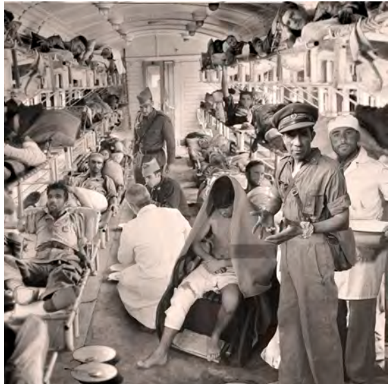
Figures 20 i 21: Àmbit 5. Museografia dedicada a les estructures i equipaments. Expositor i iconografia dedicats a estructures i equipaments en el context de la Batalla de l'Ebre (Fotos DIDPATRI).
