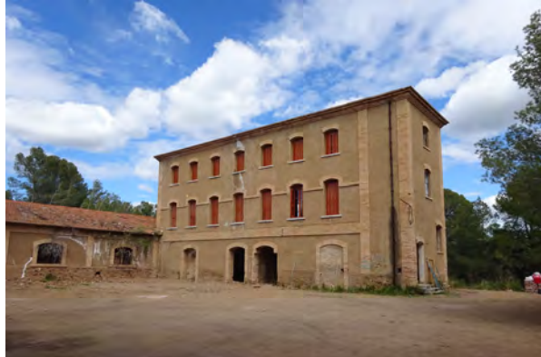
Figura 1: Edifici de direcció i serveis de la Mina Linda Mariquita on es va instal·lar, el 1938, un hospital (Foto DIDPATRI)
