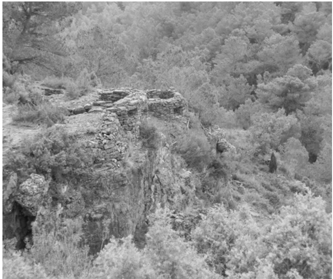
Imatge 11: Parapets de pedra seca penjats sobre un cingle a Villamalur. Fons fotogràfic de l'autor per al projecte Rutes de Memòria.
