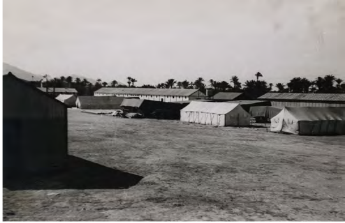
Fig. 13. Aspecto que presentaba el campo de trabajo republicano de Albaterra durante sus primeros meses de actividad. La toma nos permite apreciar la existencia de varios pabellones ya terminados, el lugar donde se encontraba el horno (delatado por el humo de la chimenea) y entre ellos un depósito de agua elevado sobre estructura de madera, todo ello en la zona más estrecha del campo, donde se situaba el acceso. Escrito a mano en el reverso: Labor constructiva en la República española. Estado actual de las obras en el Campo de Albaterra. (Reportaje Caireles; día 12 febrero) . Fuente: Biblioteca Digital Hispánica (Biblioteca Nacional), GC-CAJA/106/1/1, Albaterra (Alicante). [Campo de concentración]. Reportajes Gráficos Luis Vidal.
