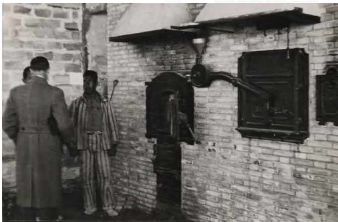
Fig. 12. Recluso mostrando a autoridades y periodistas el horno para la elaboración del pan. Febrero de 1938. Fue encargado a los Talleres Colectivizados Balart, de Sabadell, tal y como podemos ver en la marca dispuesta sobre la puerta de fundición. Escrito a mano en el reverso: Labor constructiva. Albatera. Instalación de hornos para la cocción de pan. (Reportaje Caireles, día 12 febrero). Fuente: Biblioteca Digital Hispánica (Biblioteca Nacional), GC-CAJA/106/1/3, Albatera (Alicante). [Campo de concentración]. Reportajes Gráficos Luis Vidal.
