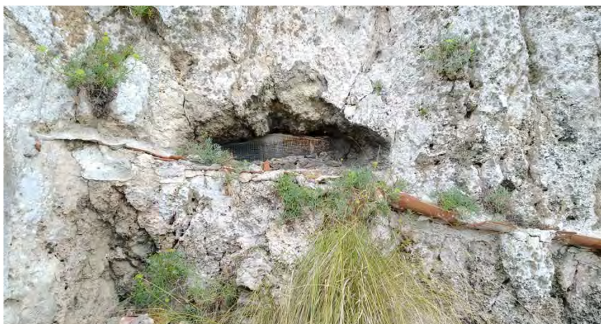
Figura 10. Niu de metralladores del túnel de la Cova Gran (Fotografia pròpia, agost del 2020).
