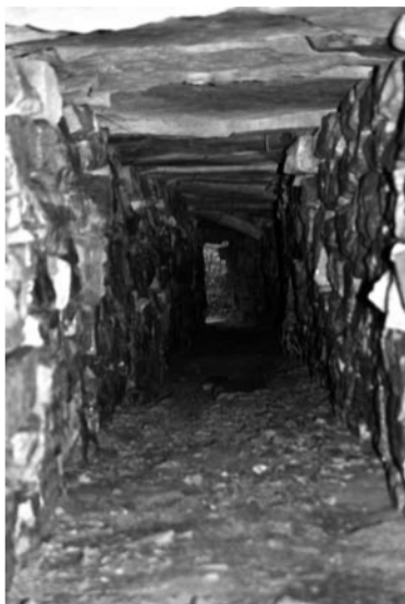
Tram superior de la mina. Sota l'enllosat del pis transcorre la canonada ceràmica. A la dreta, els dos broiladors de la sortida de les dues probables mines. El broilador de dalt, fosc, rajant, i l'altre brocal, el més proper, sec des de fa anys.
