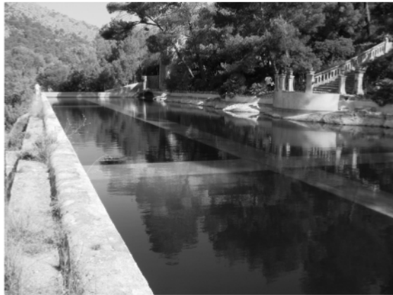
Fotografia 14. Estat actual del safareig monumental de Raixa. (J. Llabrés)
