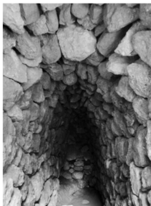
Fotografies 7 i 8. Mina de la font dels Polls de Pastoritx i canaleta per on discorre l'aigua en el tram final per arribar a Raixa. (D. G. Murray)
