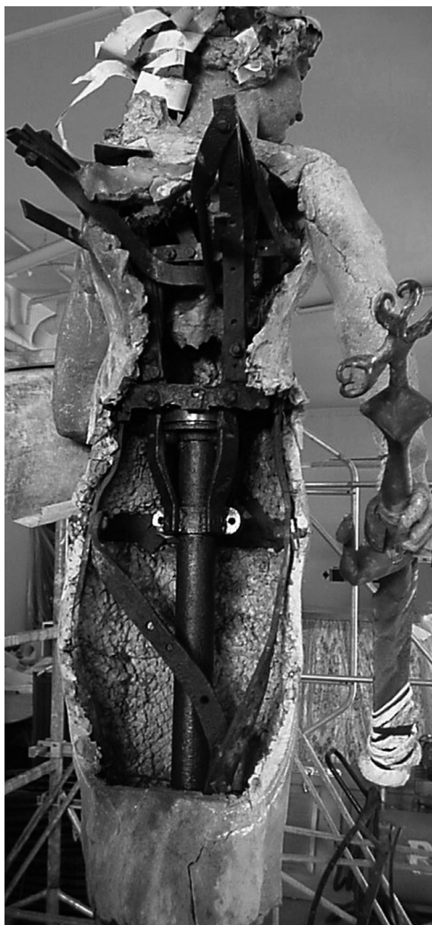
12. Detall posterior del cos de l'àngel un cop obert per a la restauració, l'any 2000. Es mostra l'eix o èmbol que permet la rotació. Fotografia cedida per Francesc Salvat.
