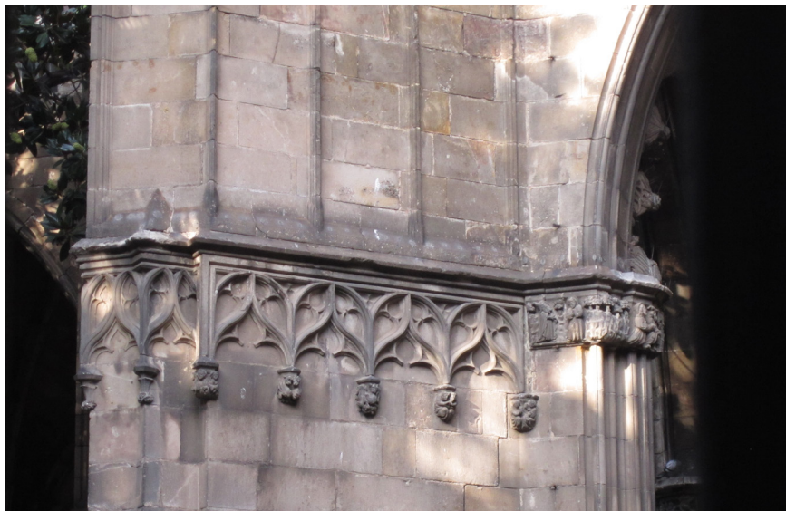
Fig. 9. Claustre de la Catedral de Barcelona. Brollador. Setzè pilar.
