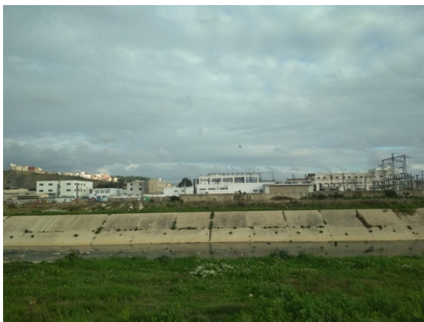
Figura 2. Obras de canalización en Tetuán (Marruecos). Fuente: original del autor.
