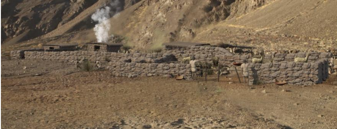
Figura 9. Modelamiento en 3D Tambo del río la sal, región de atacama. Elaboración propia del equipo de trabajo de la Universidad de Valparaíso, para la oferta turística (2019).
