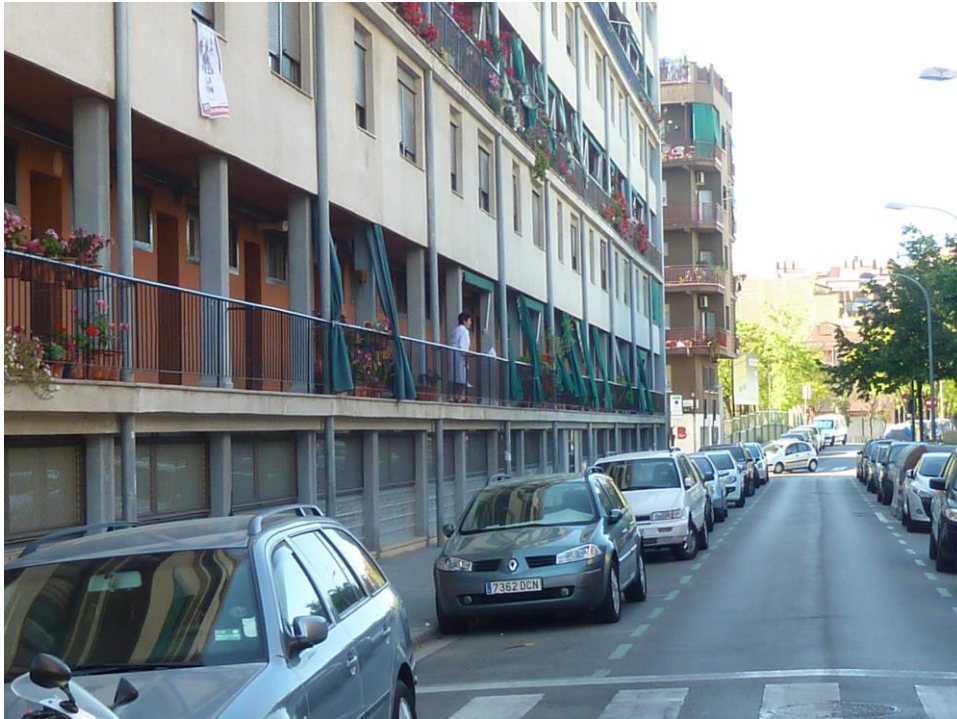
Imagen 9.- Casa Bloc: Vista de una de las fachadas con los corredores ocupados por los vecinos.
