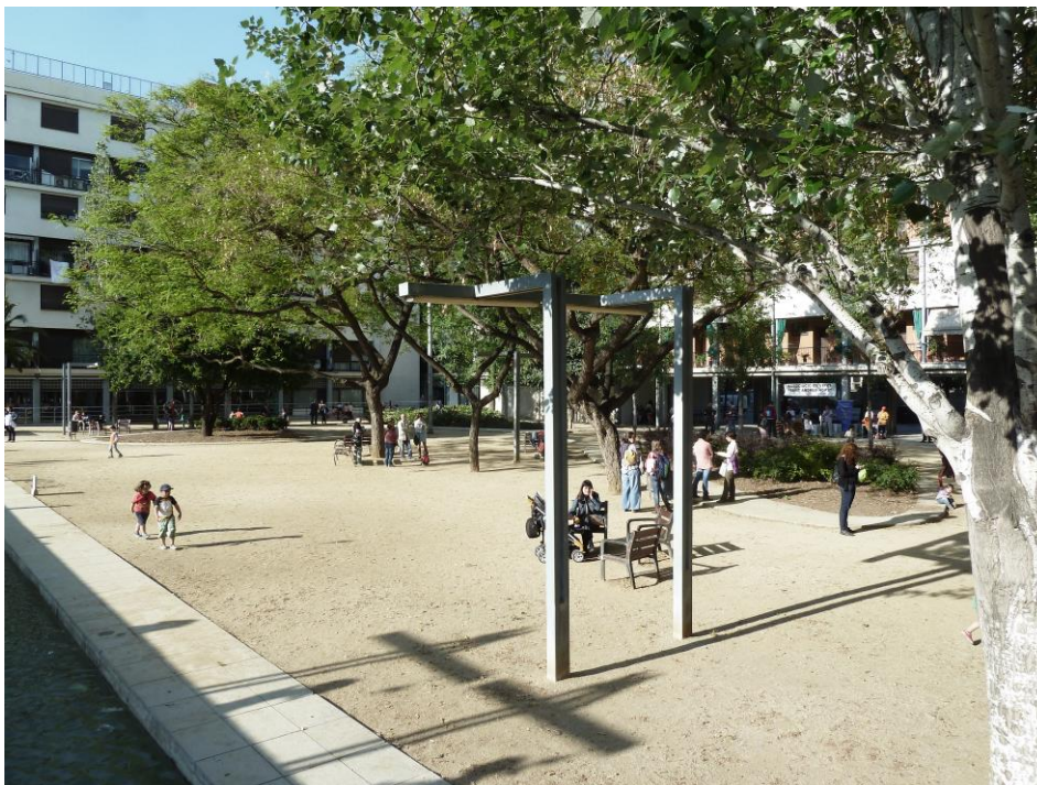
Imagen 10.- Casa Bloc: Vista de uno de los espacios exteriores vinculados a viviendas y a equipamientos.
