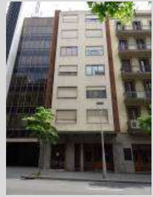
1934-1935. R. Ribas Seva. Edificio. Balmes, 166
