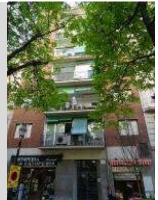
1931-1933. P. Benavent. Casa Torres. Avda. Gaudí, 56
