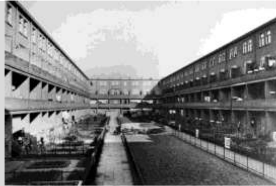
Rotterdam, Innenhof eines Wohnblockes 1921-23J. J. P. Oud
