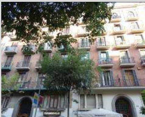
1927. Pere Benavent. Edificio Calle París, 175-177
