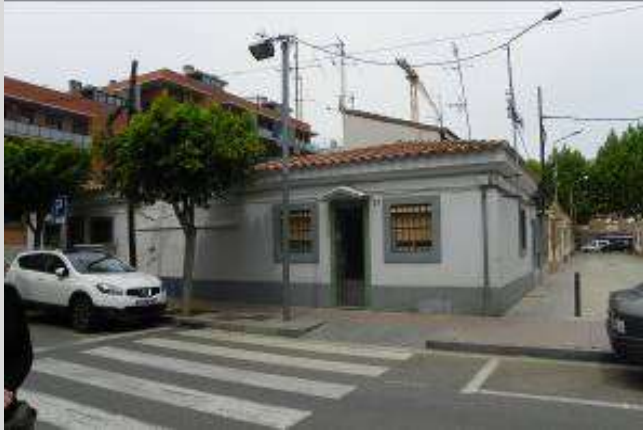
Vista actual de las casas existentes en el polígono de Bon Pastor
