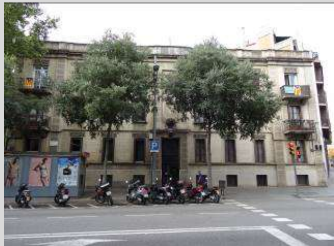
1918. Casas baratas en bloque, Passeig Maragall, 391
