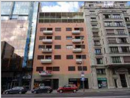
1930-1931. German Rodríguez Arias. Casa Rodríguez Arias. Via Augusta, 61
