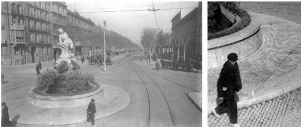
Fig. 20-21 Font de Diana a la Gran Via de les Corts Catalanes. Arxiu Nacional de Catalunya. Brangulí 1920-1925. ANC1-42-N-29598
