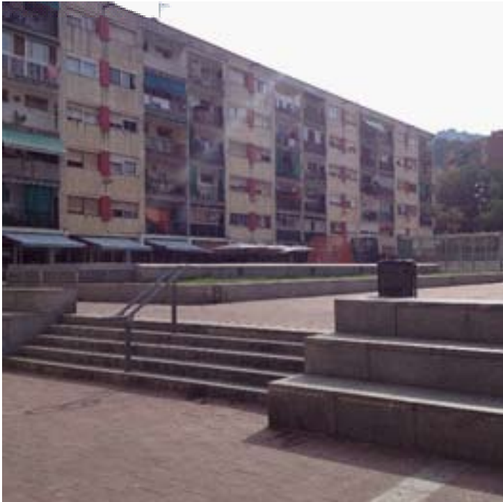
Fig. 27. Imagen espacios interbloques
