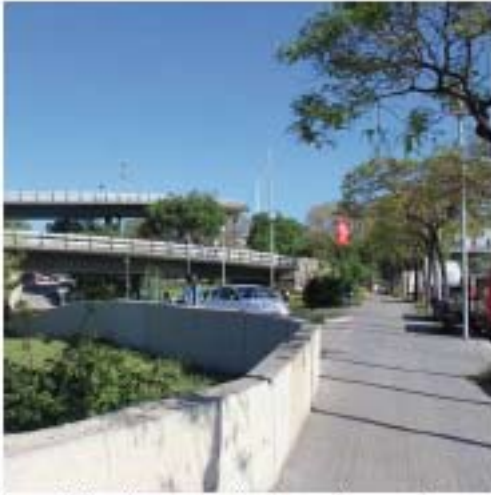
Imagen 7: Vista del acceso estación de metro. fuente propia
