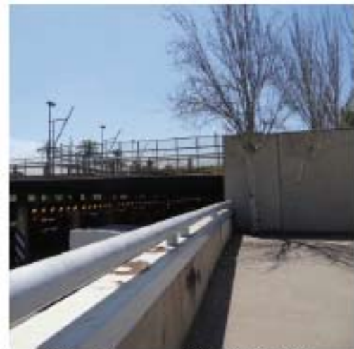
Imagen 12: Escalera de acceso a la plataforma Bon Pastor. fuente propia
