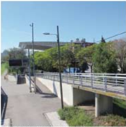
Imagen 8: Rampas de acceso a parque del Besos. fuente propia
