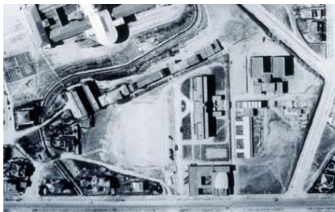
Figura 3-A Foto del ejército del Aire de la Colina de los Chopos, Madrid, 1938. (Norte y la escuela Primaria en ejecución de obra a la derecha, calle Serrano abajo.)
