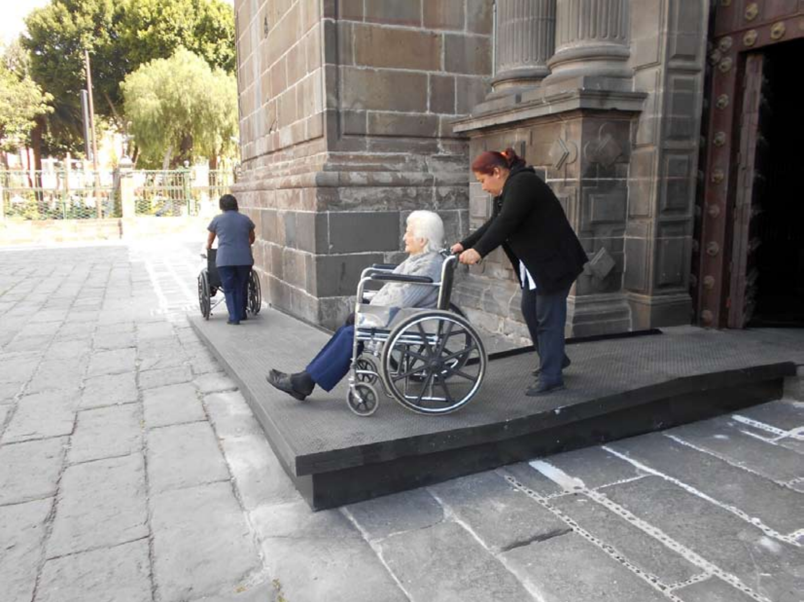
Basílica Catedral: Rampas en accesos desde banquetas y hacia interiores, con pendientes adecuadas y guía en el piso del atrio que indica recorrido recomendado entre las rampas. (Re Genera Espacio, 2016)
