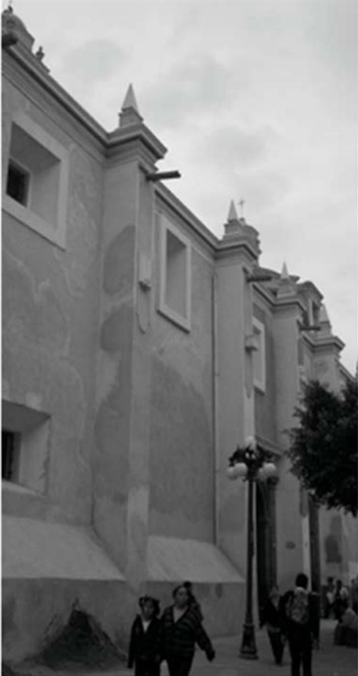
Templo de Santa Mónica, previo a intervención en accesos. (Re Genera Espacio, 2015)
