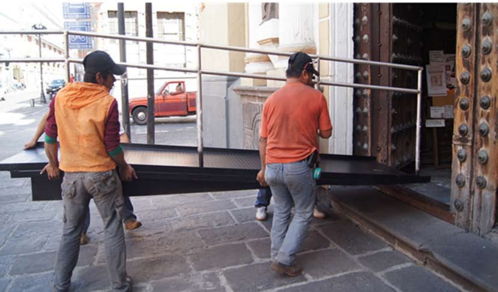
San Juan de Letrán "El Hospitalito": Colocación de rampa metálica y uso por parte de los feligreses. (Re Genera Espacio, 2016)
