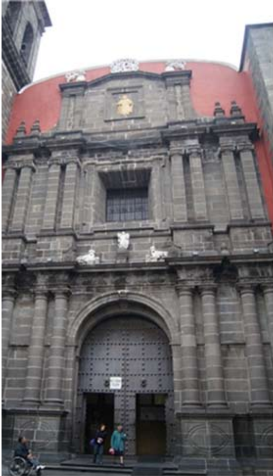
Santo Domingo, previo a intervención: Rampas angostas y con pendientes pronunciadas en atrio y acceso al templo. (Re Genera Espacio, 2015)
