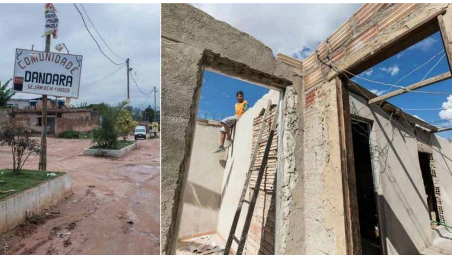
Figuras 4 y 5: Entrada de la ocupación Dandara y casa en construcción. Obtenidas de: https://www.bbc.com/portuguese/brasil-38402603
