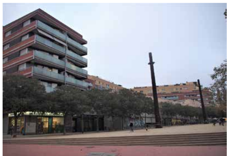
Ilustración 22. Paseo Posoltega escoltado por los dos conjuntos residenciales diseñados por MAP Arquitectes. El Paseo Posoltega es formalmente una continuación del Parque de la Maquinista hacia el Centro comercial que se ve al fondo. Fuente: Elaboración propia
